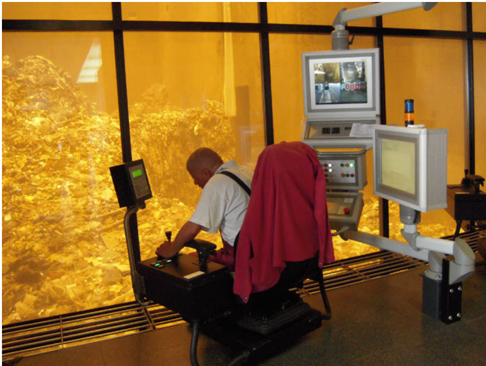
Kommandoraum der Kehrichtverbrennungsanlage Thun
